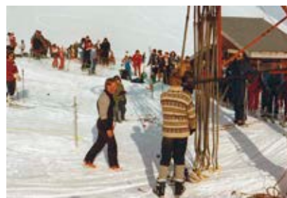
Forstöðumaður skíðasvæðisins árið 1983, á göngu við startið í Gullhólslyftunni sem var neðri lyftan á Seljalandsdal.
