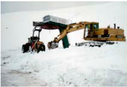
■ Endastöð Sandfellslyftunnar að rísa.
