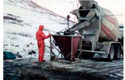
■ Steypuvinna við Sandfellslyftuna.
