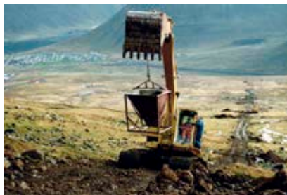
■ Unnið við undirstöður nýrrar lyftu á Seljalandsdal.
