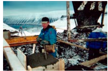
Þorlákur Baxter að steypa undirstöður Miðfellslyftunnar, rétt sést í Palla Stull bak við steypusílóði.
