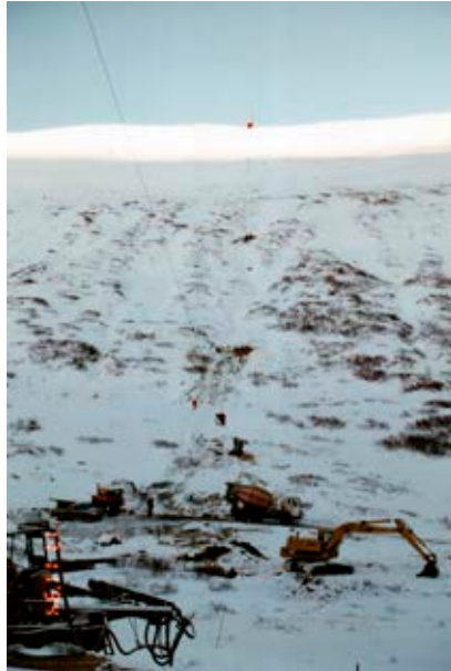
■ Unnið við Sandfellslyftuna.
