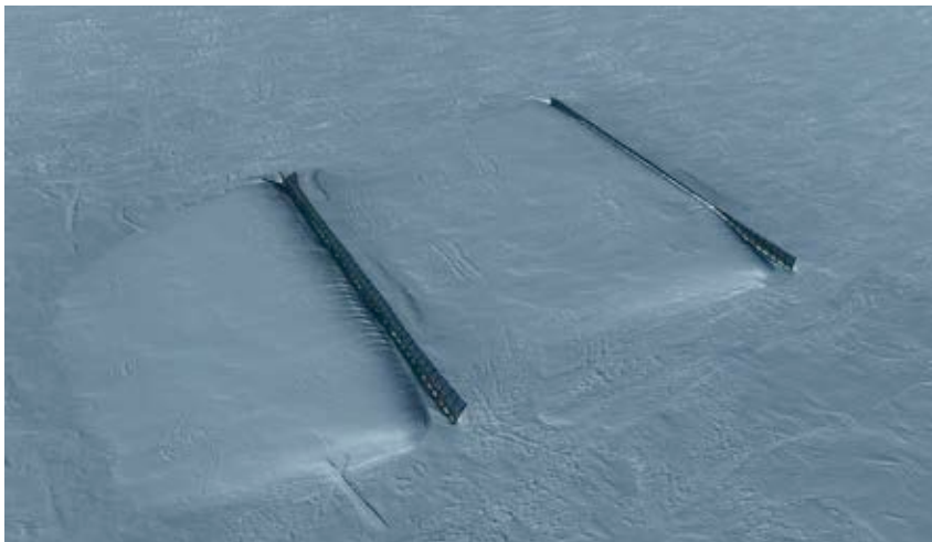
■ Mynd 1. Snjósöfnunargirðingar á Eyrarfjalli ofan Flateyrar í apríl 2024. Girðingarnar eru 5 m háar í tveimur 150 m röðum. Áberandi skaflar eru suðvestan við grindurnar. Mynd: Veðurstofa Íslands, Örn Ingólfsson.
