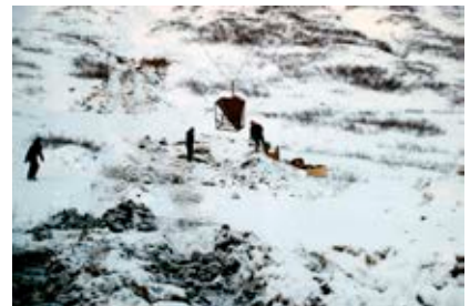
■ Steypan hífð upp í brekkuna fyrir undirstöður Sandfellslyftu.
